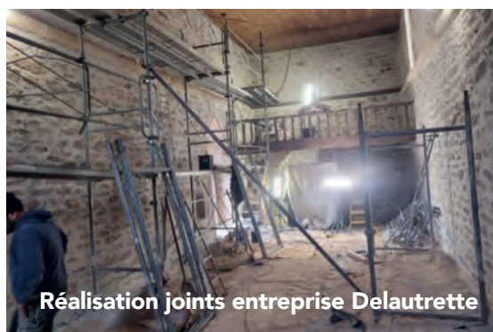
Enlèvement ancien enduit en régie
