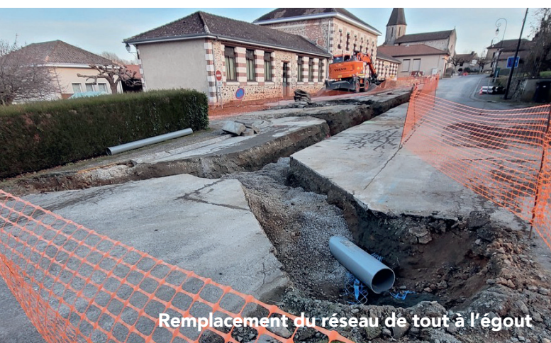
Remplacement du réseau d'eau
